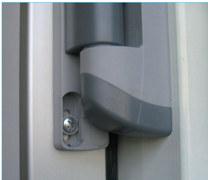
Sistema di regolazione con passo 1 mm Adjusting system with thread 1 mm
